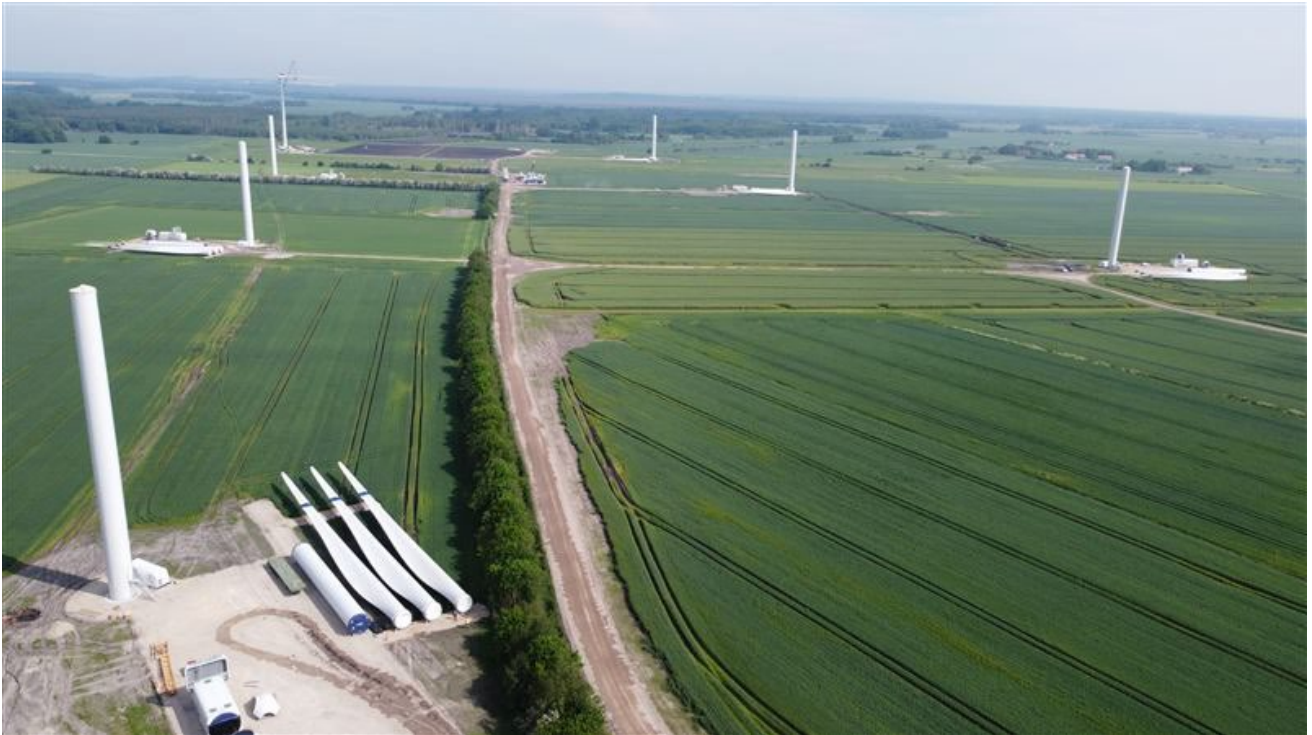
Figur 5-6. Eksempel på anlægsarbejde ved opstilling af Vestas vindmøller ved Vedum Kær.
