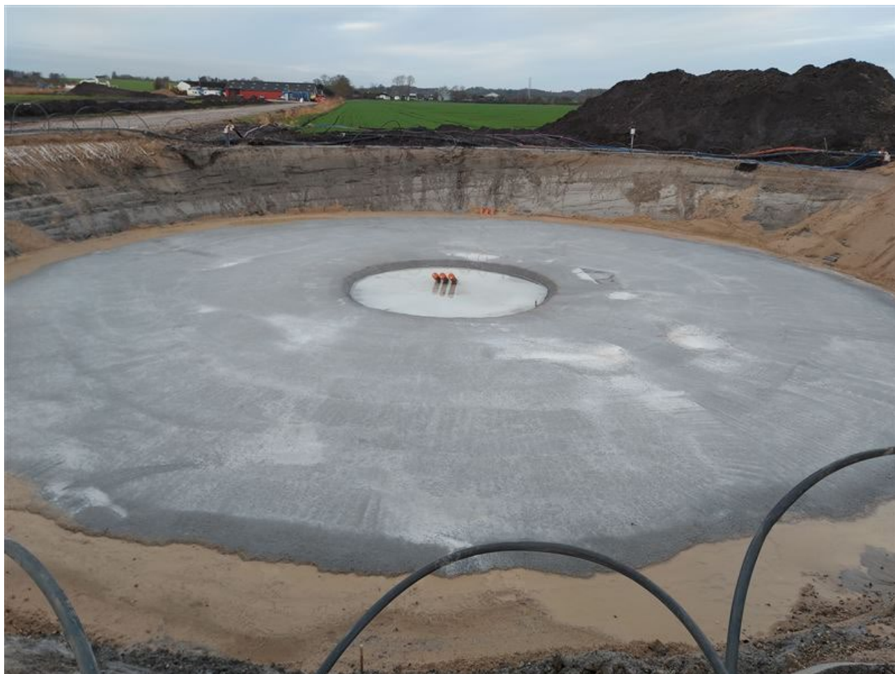
Figur 5-5. Eksempel på pladefundament til en Vestas vindmølle.
